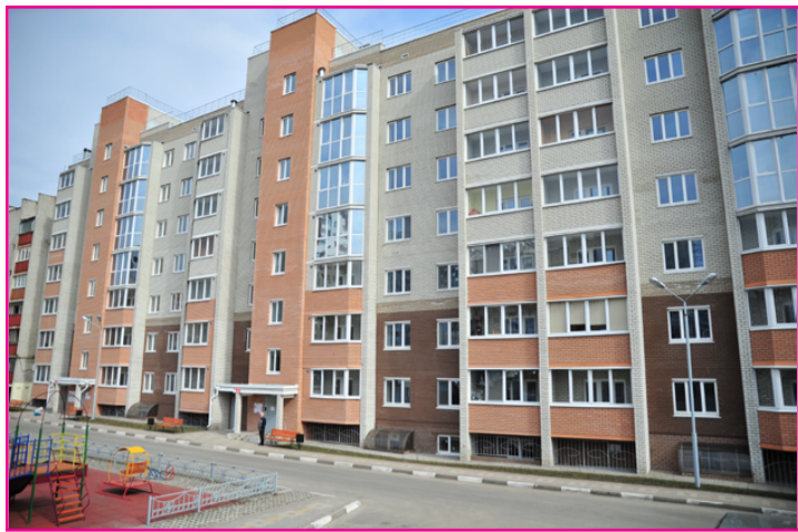
Энергоэффективный дом по ул. Дзержинского, 10
